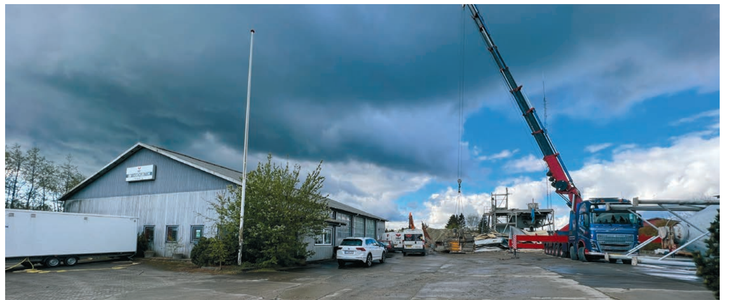
Das ehemalige Betonmischwerk am Håndværkersvinget wird beseitigt.
