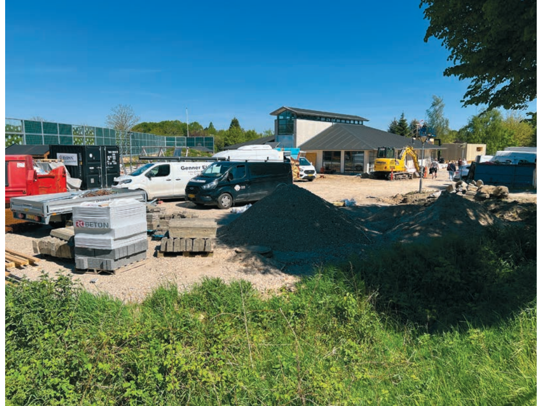
Hier am Bomhusvej entsteht ein Betreuungsangebot für 60 Kinder.
