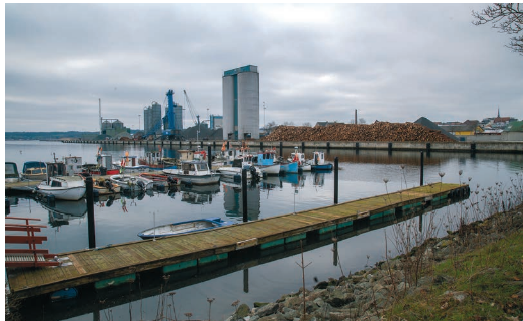
Die Unternehmen rund um den Nyhavn sind in den Prozess einbezogen worden. Sie bangen um ihren Standort. Gleichzeitig soll der Schutz vor Überschwemmungen besser gesichert werden (Archivfoto).
