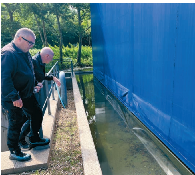
Klaus Viggo Jørgensen und Thomas Matzen am Wassergraben neben dem blauen Kubus. Die Wassermengen werden unterirdisch gereinigt und durch das Rohrsystem geleitet.
