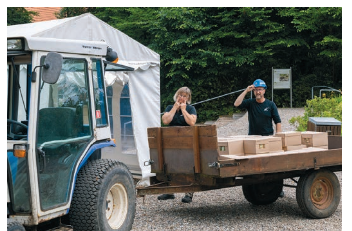
Nach tagelangen Vorbereitungen begannen nach der Absage gleich die Abbauarbeiten. Diese könnten bis Mitte dieser Woche andauern.
