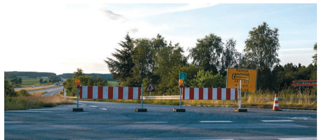
Diese Woche starten Asphaltarbeiten auf der E45 bei Woyens (Symbolbild).
