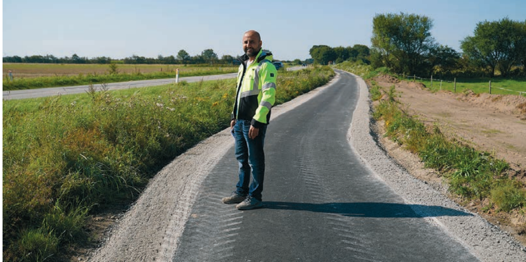
Bauingenieur Arshad Aazam auf dem neuen Radweg, der noch nicht komplett fertig ist.
