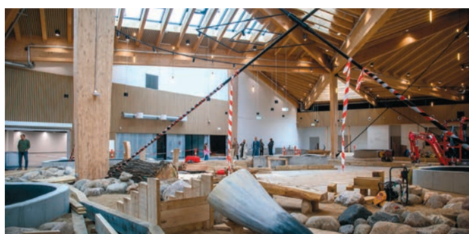
Im Restaurantgebäude entstehen Spiel- und Essbereiche.
